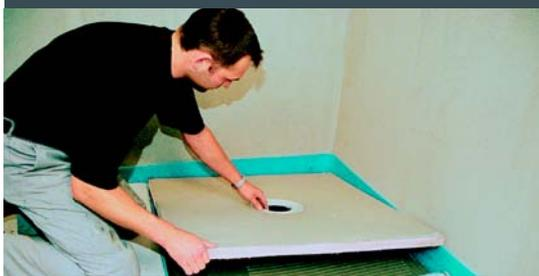
Unterbau für bodengleiche Duschen: Die EPS-Schaumqualität von 60 bis 100 kg/m<sup>3</sup> bietet eine hohe Druckfestigkeit, so dass PCI Pecibords rollstuhlbefahrbar sind
