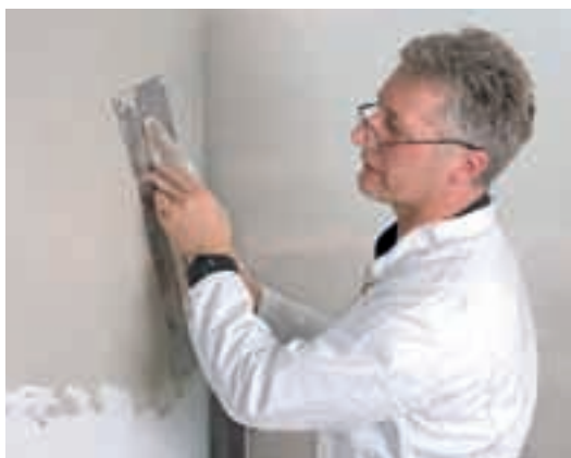
Faszinierend: Verspachtelungen mit Readygips erfüllen höchste Anforderungen
