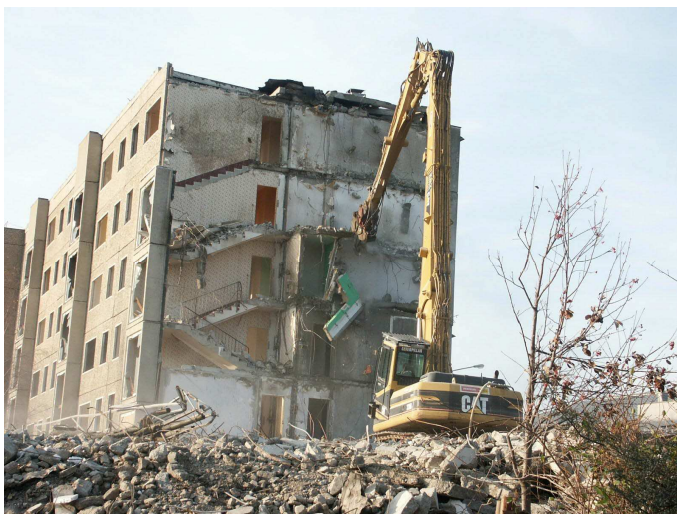
Abbruch eines Plattenbaus, Foto Dittrich, IÖR
