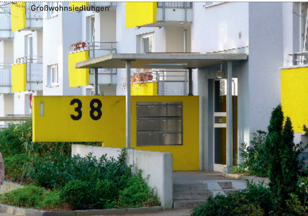
Signalwirkung Farbe: mehr als nur ein Fassadenanstrich
