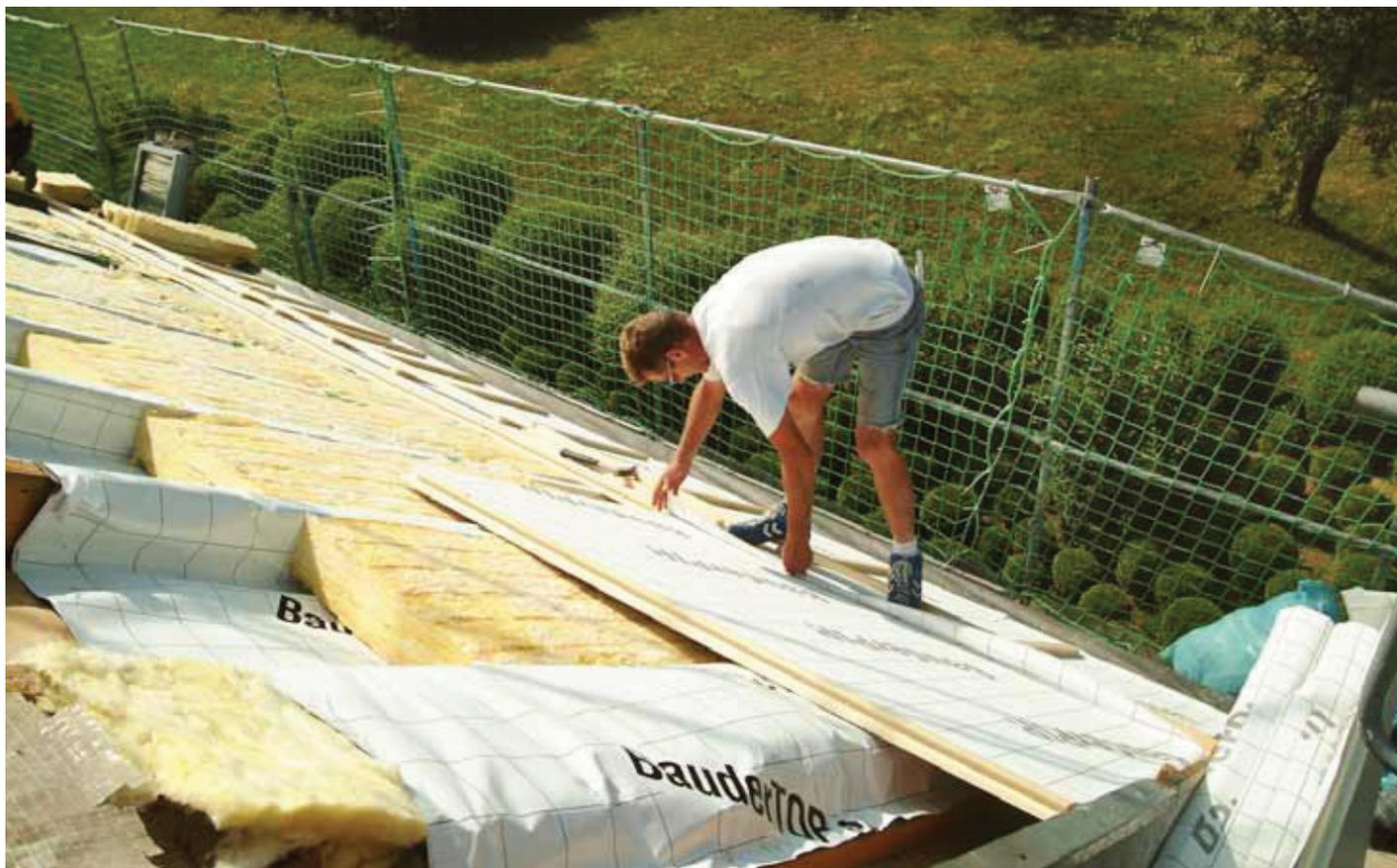
Verlegung des Kombidämmsystems BauderPIR und neuer Zwischensparrendämmung
