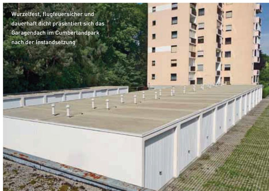
Wurzelfest, flugfeuersicher und dauerhaft dicht präsentiert sich das Garagendach im Cumberlandpark nach der Instandsetzung
