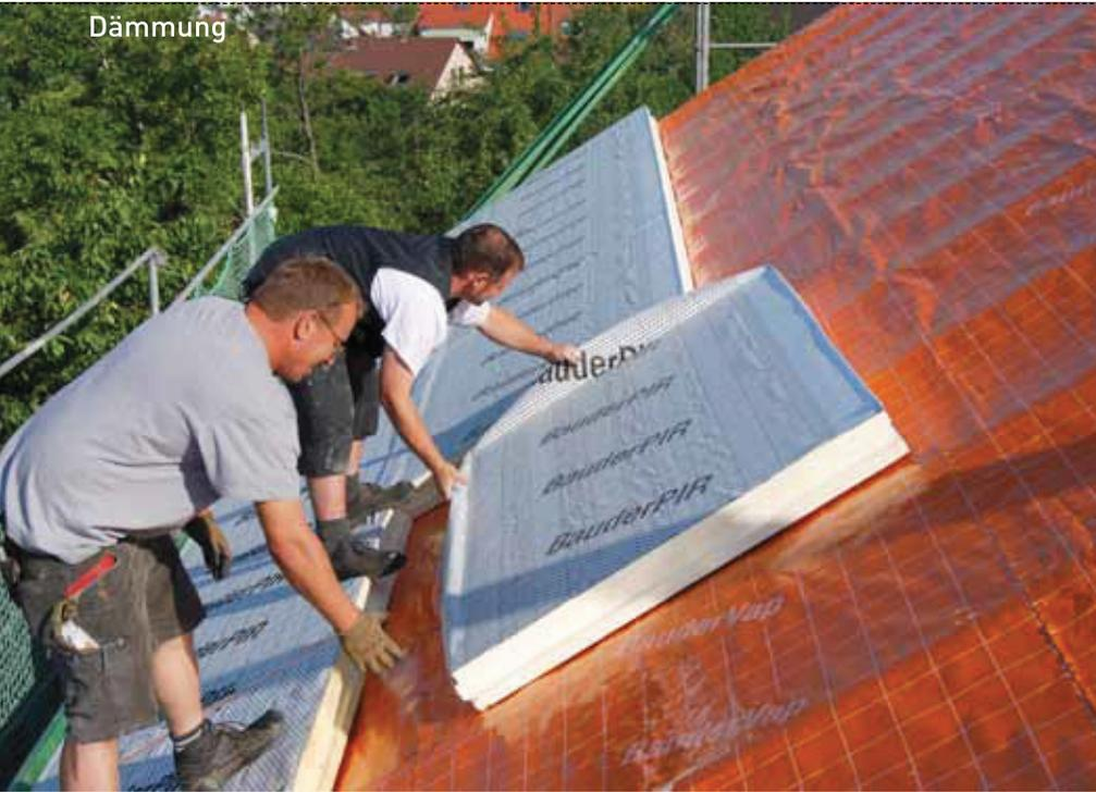
Die Verlegung einer Aufsparrendämmung mit Polyurethan-Hartschaum PUR/PIR. Trotz gutem Wärmeschutz ist das Dämmpaket vergleichsweise leicht und dünn
