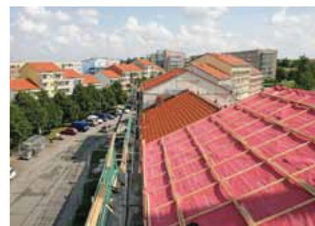
Dachdeckung im System: Unterspannbahn, Abklebeband, dem Nageldichtmaterial und Hochleistungsanschlusskleber
