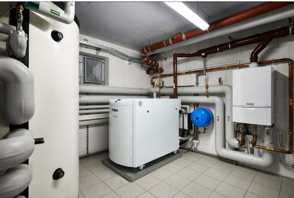
Kompakt, übersichtlich – und dabei effizient: in der Mitte die gasbetriebene KWK-Anlage, rechts das Gas-Brennwertgerät mit 65 kW Leistung und links der Pufferspeicher mit 1400 l Inhalt
