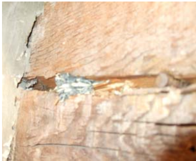
Holzriss aufgebohrt und abgedichtet
